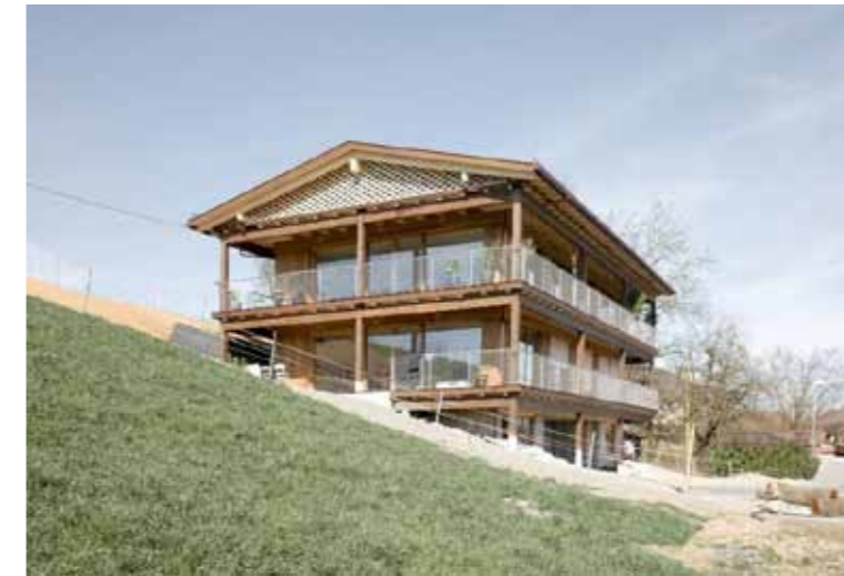
Das Mehrfamilienhaus Chriesimatt in Udligenswil wurde mit 90,2 m3 Schweizer Holz realisiert.
